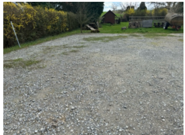
Abb. 11: Geschotterter Platz im nördlichen Bereich des Plangebiets.
