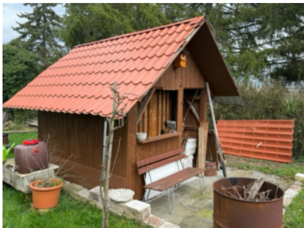
Abb. 16: Blick auf die Geschirrhütte mit gelagertem Material aus südwestlicher Richtung.
