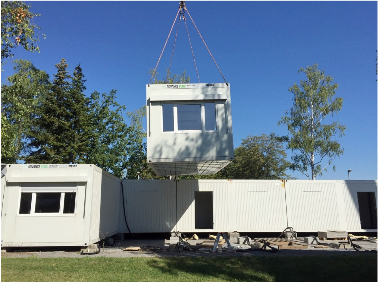
Die einzelnen Containerelemente werden mit dem Autokran angehoben und zum Sattelzug transportiert.
